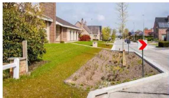
Figuur 34. Voorbeelden van gat in boordsteen (links onder) en verlaagde wegversmalling (rechts onder). Bron: Aquafin
