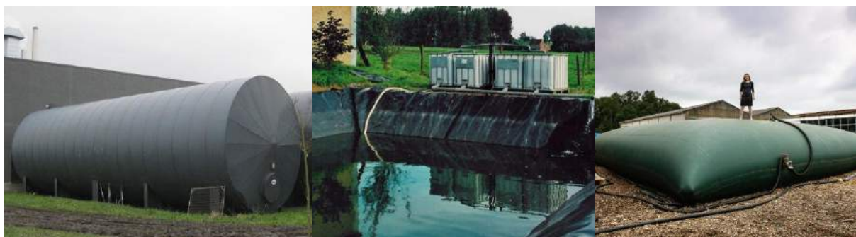
Figuur 50. Buffertanks, een foliebekken en een zak, voor de opslag van regenwater (Bron: Departement Landbouw en Visserij; Provincie Oost-Vlaanderen; De Standaard).
